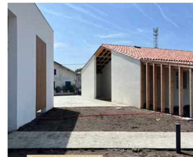
Travaux de la MAM / MIC
